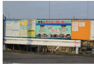
耐震補強工事中の古川橋
