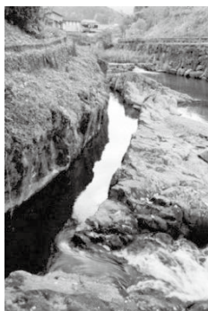
仰西渠の明渠
