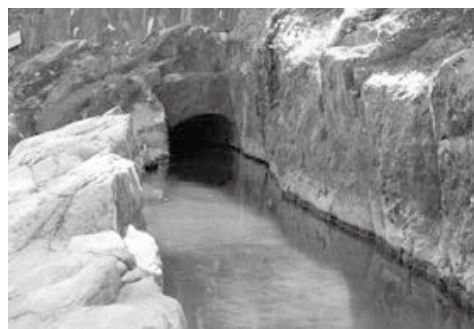
仰西渠の暗渠
