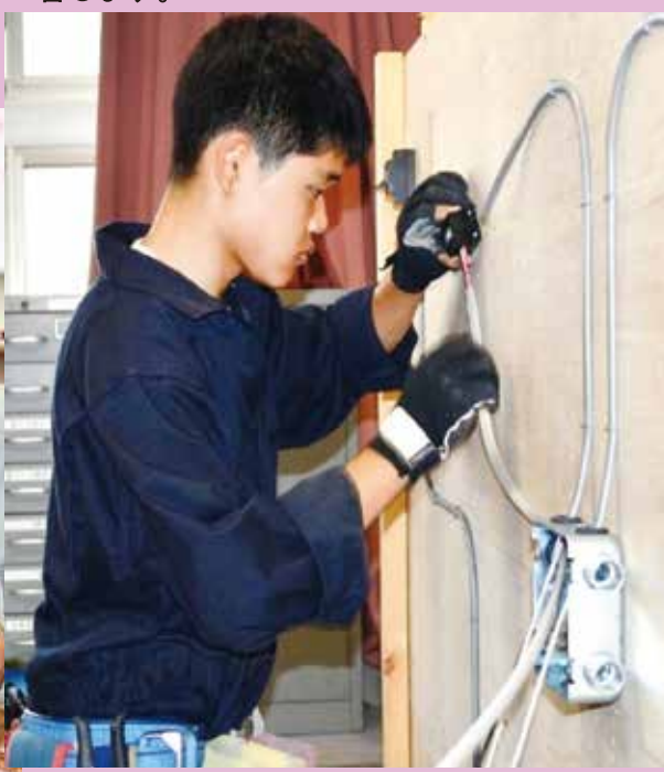
電気工事実習(電気・情報系) 電気工事士の実技試験に対応した配線実習で、第二種電気工事士合格を目指します。
