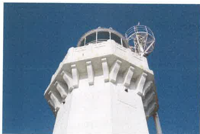
灯塔上部 (灯塔高：18m)
