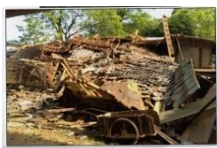
【学校施設被害状況 1】
