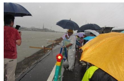
河川工事の様子の見学
