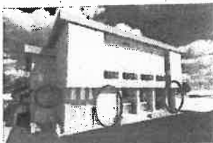
【外観 ※○新設耐震壁】
